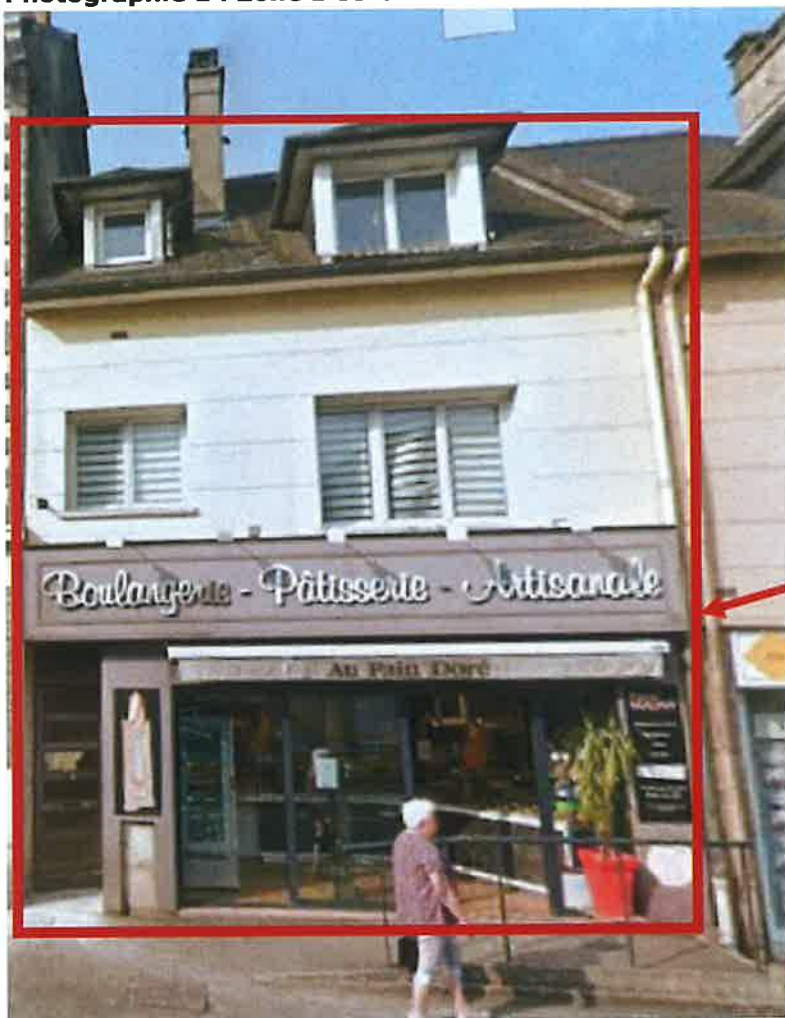
Photographie 1 : Zone à échafauder
